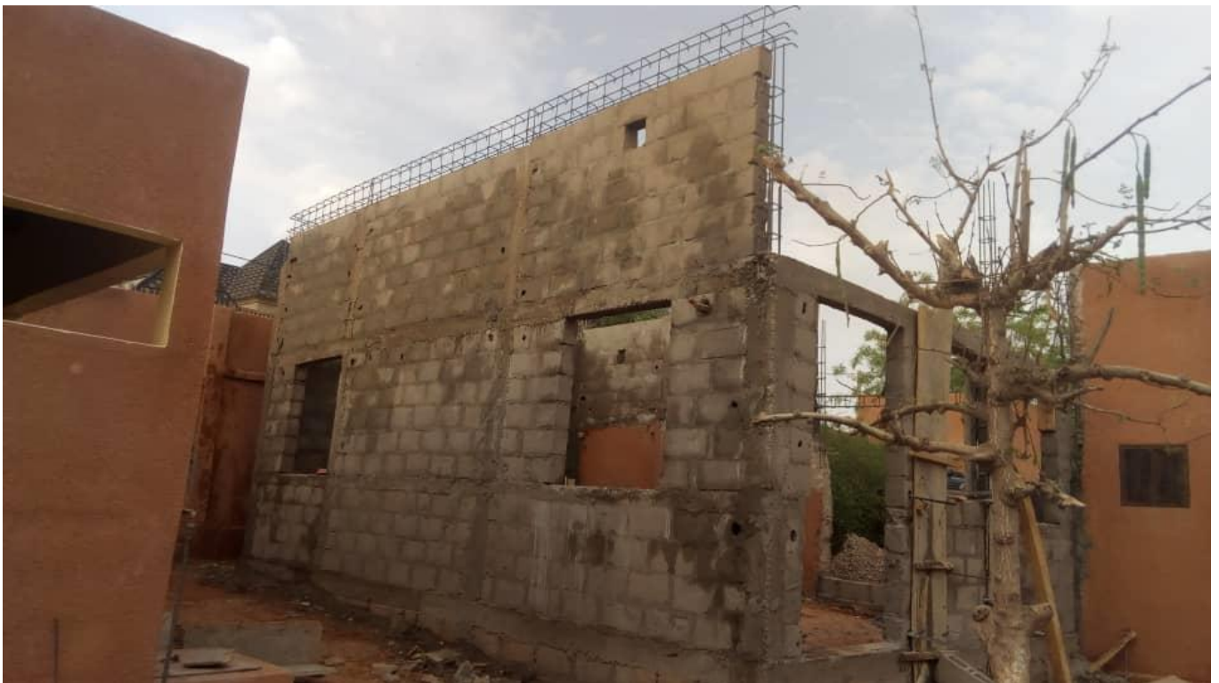
Das neue Lokal für die Kinder des Kindergartens, im Bau - März 2020
